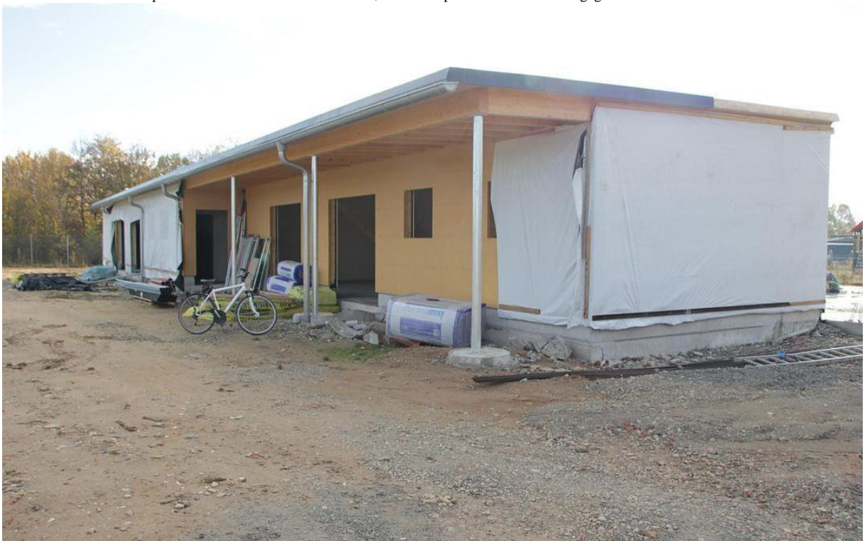
Der Rohbau für das neue TSV-Sportheim steht. Foto: Andreas Dorsch
