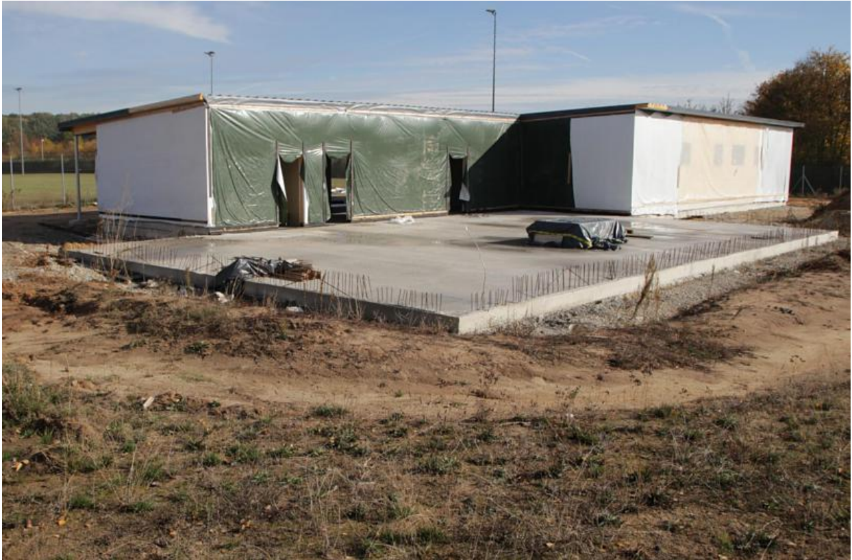
Der Rohbau des neuen Sportheims vom TSV Höchststadt steht, die Bodenplatte für die Halle ist gegossen. Foto: Andreas Dorsch
